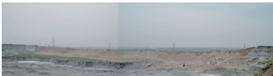
图 23 不当取灰导致灰坝倒塌
