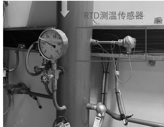
图5 测温电阻安装图
