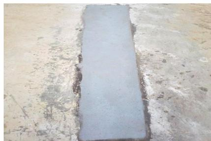
图8 浇筑SK-PAM 特种抗冲磨树脂砂浆
