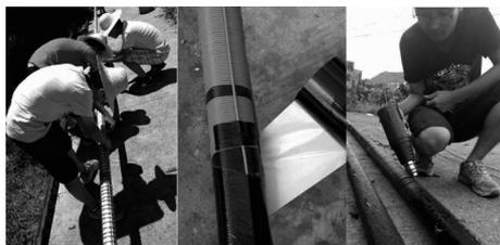
图7 碳纤维内加热光缆布设图
