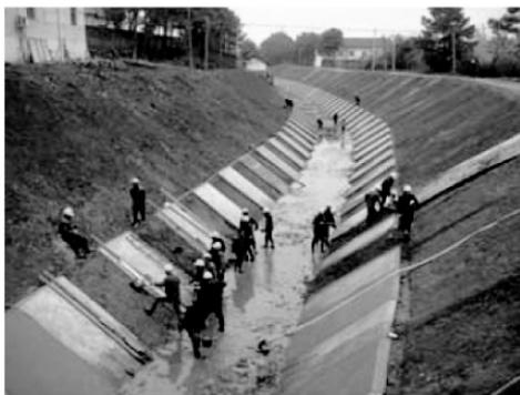
图6 第2期隔板跳仓浇筑渠坡混凝土
