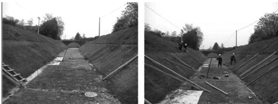
图2 渠坡及基础清理整形后
