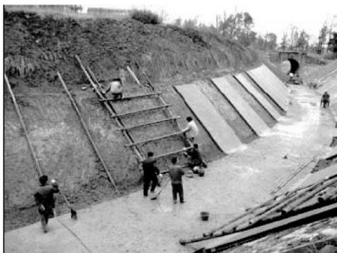
图5 第1期隔板跳仓浇筑渠坡混凝土
