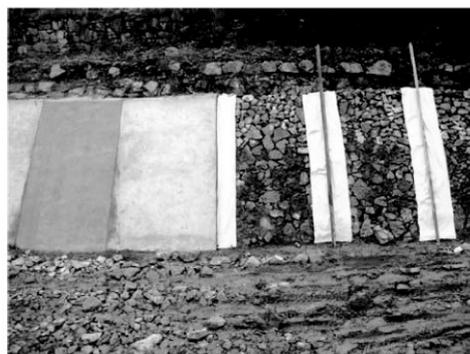
图4 分缝处基底表面铺设土工膜
