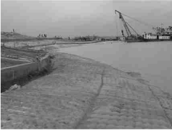
图9 分块模袋固化砂浆排等护岸施工现场
