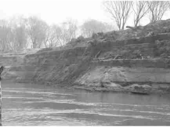
图 1 江新洲试验工程施工前崩岸现场原貌
