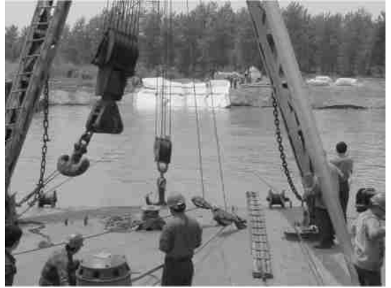
图10 管袋固化砂浆软体排的拖拉铺排施工
