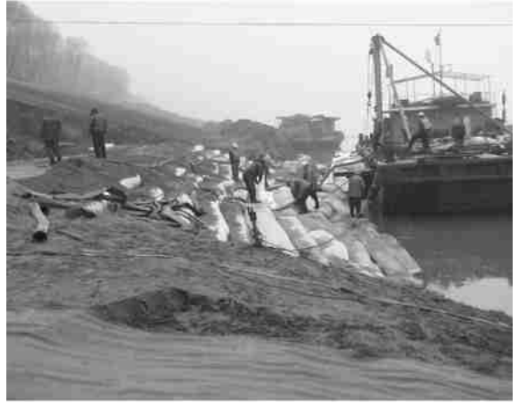
图 13 江新洲试验工程窝崩抢险施工现场
