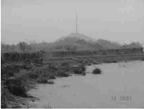
图5 东梁山试验工程施工前崩岸现场原貌
