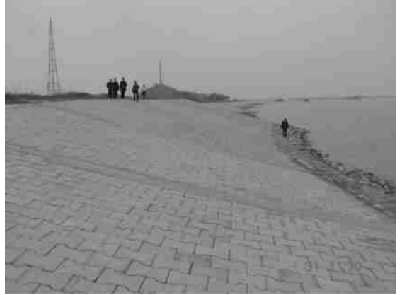
图6 东梁山试验工程治理后现状
